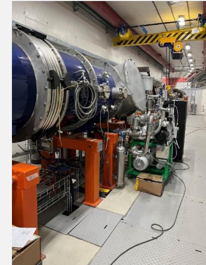
Монтаж септума инъекции последнего элемента криомагнитной системы Коллайдера 15 ноября 2025 г.
