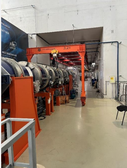
Монтаж криомагнитной системы Коллайдера
