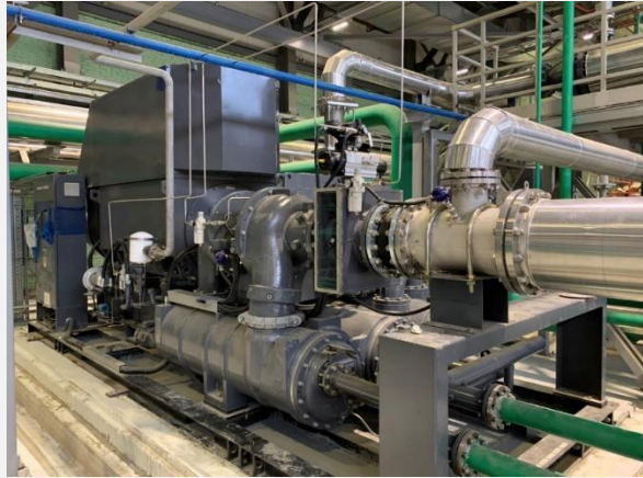
Азотный компрессоры Аэроком - 2 179/18 и Hanwha Techwin SM5000
