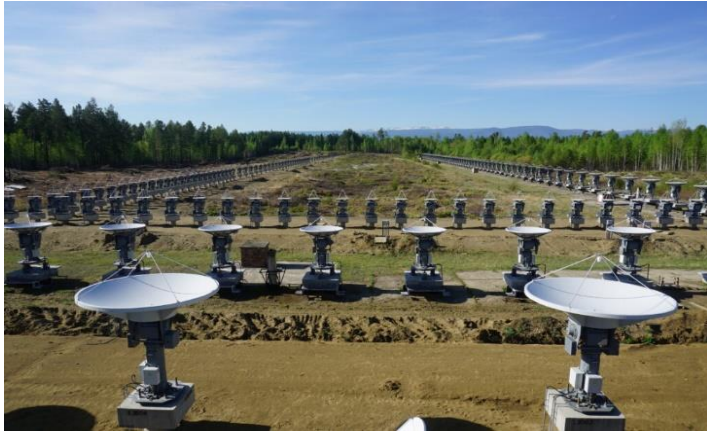
Вид части антенной системы
